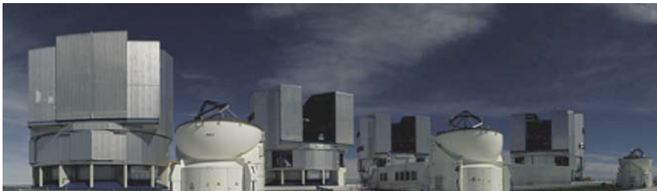
Εικόνα 4. Το συμβολομετρικό τηλεσκόπιο VLT στο Ευρωπαϊκό Αστεροσκοπείο του Νότιου Ημισφαιρίου ESO, στο όρος Παρανάλ της Χιλής (υψόμετρο 2635μ). Αποτελείται από 4 τηλεσκόπια με κάτοπτρα διαμέτρου 8.2 μ το καθένα. Όταν λειτουργούν όλα μαζί σε συμβολομετρική διάταξη, η συνολική τους ισχύς ισοδυναμεί με τηλεσκόπιο διαμέτρου 16 μ. © European Southern Observatory.
