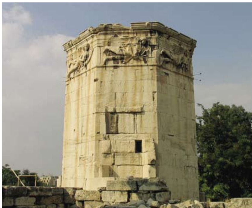
Εικόνα 1. Αέρηδες-Ο Πύργος των ανέμων: Τεράστιο υδραυλικό ρολόι με τους οκτώ ανέμους και ισάριθμα κατακόρυφα ηλιακά ρολόγια στις πλευρές του.
