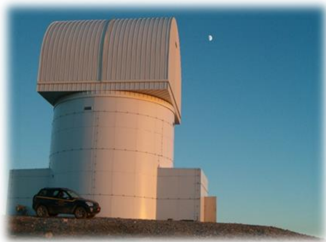
Το κτίριο του θόλου στο Αστεροσκοπείο Χελμού που στεγάζει το τηλεσκόπιο «ΑΡΙΣΤΑΡΧΟΣ».
