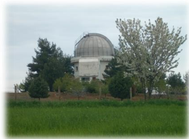
Το κτίριο του θόλου στο Αστεροσκοπείο Κρουονερίου που στεγάζει το τηλεσκόπιο με διάμετρο κατόπτρου 1.23 μ.
