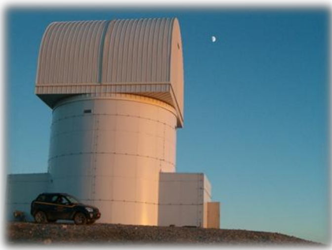
Το κτήριο του θόλου στο Αστεροσκοπείο Χελμού που στεγάζει το τηλεσκόπιο «ΑΡΙΣΤΑΡΧΟΣ».
