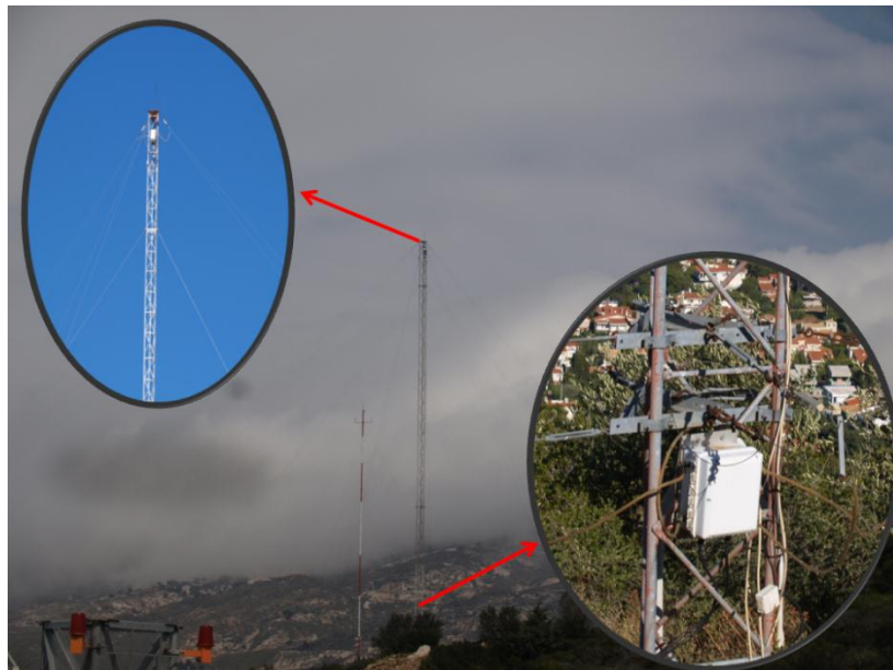
Η κεραία εκπομπής του ιονοσφαιρικού σταθμού αποτελείται από δύο στελέχη τύπου \Delta με προσανατολισμό A- \Delta και B-N. Ο ιστός έχει ύψος 30 m.
